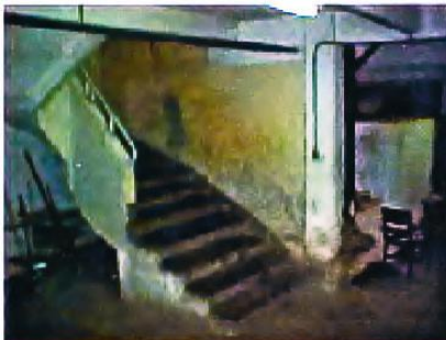
*Acesso ao Subsolo, 2002
