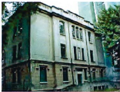
*Saída de Emergência, 2002
