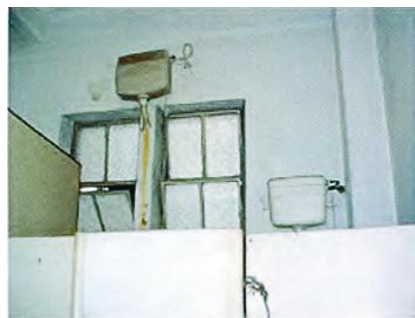
*Banheiro Masculino Térreo, 2002
